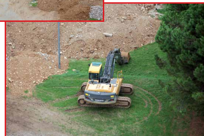
In cantiere del nuovo oratorio
